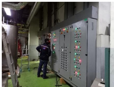
ตู้ควบคุม Transfer Pump
